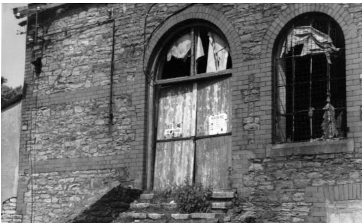
Aber Colliery Fan House c.1980
